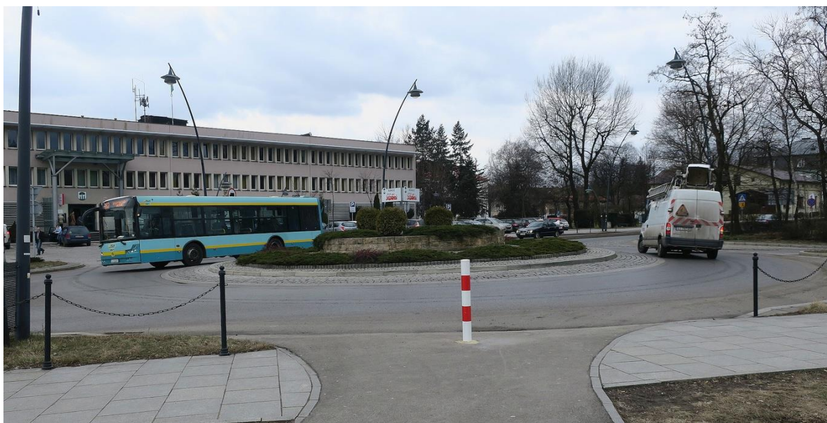
Rys. 24A. Dwukierunkowa droga dla rowerów jako samodzielny wlot małego ronda. Znak C-13a na końcu drogi dla rowerów jest opcjonalny (skrzyżowanie zawsze odwołuje wcześniej umieszczony znak C-13); jeśli się go stosuje to powinien być umieszczany w odległości 10 m przed znakami A-7 i C-12.
