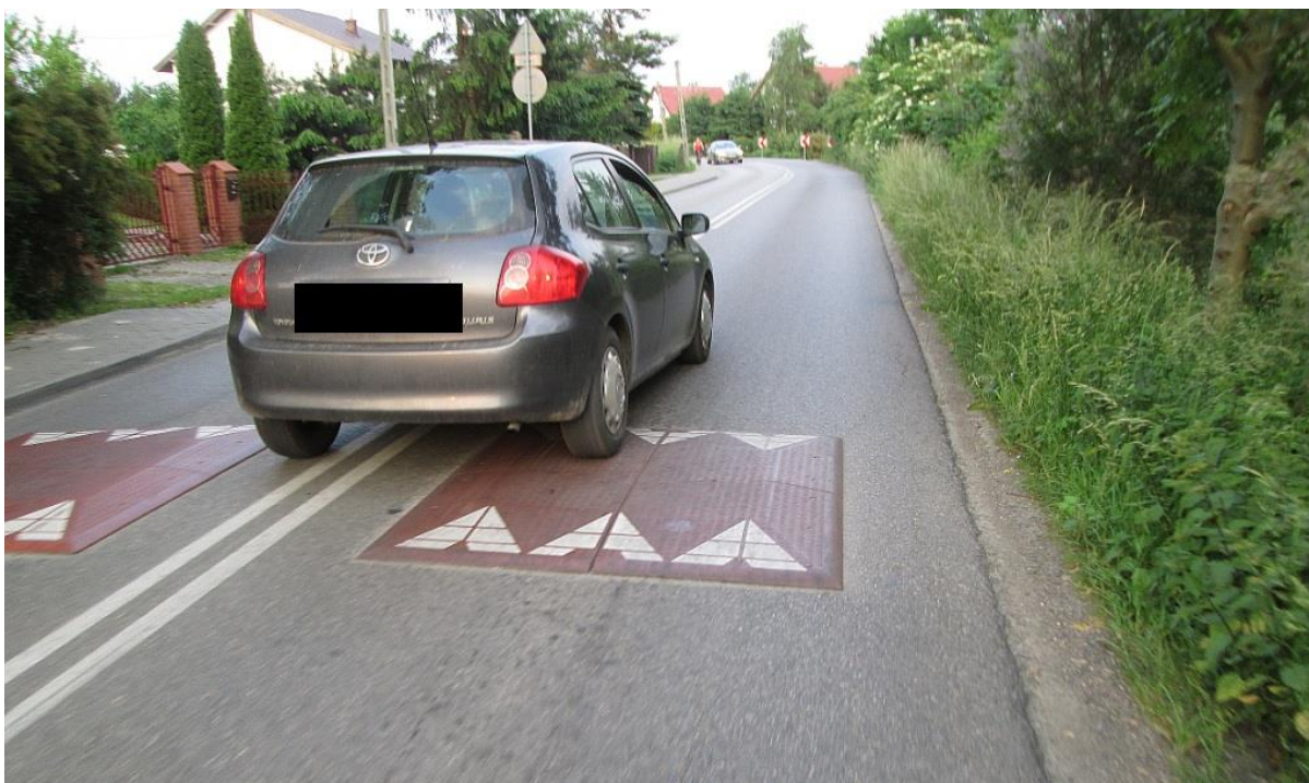
Fot. 2. Przykład uspokojenia ruchu przy pomocy prawidłowo umieszczonych progów wyspowych (niemożliwe jest ominięcie progu samochodem przez jazdę środkiem jezdni – widoczny na zdjęciu pojazd przekracza linię P-4, bo wcześniej wyprzedzał rowerzystę). Piekary koło Krakowa.
