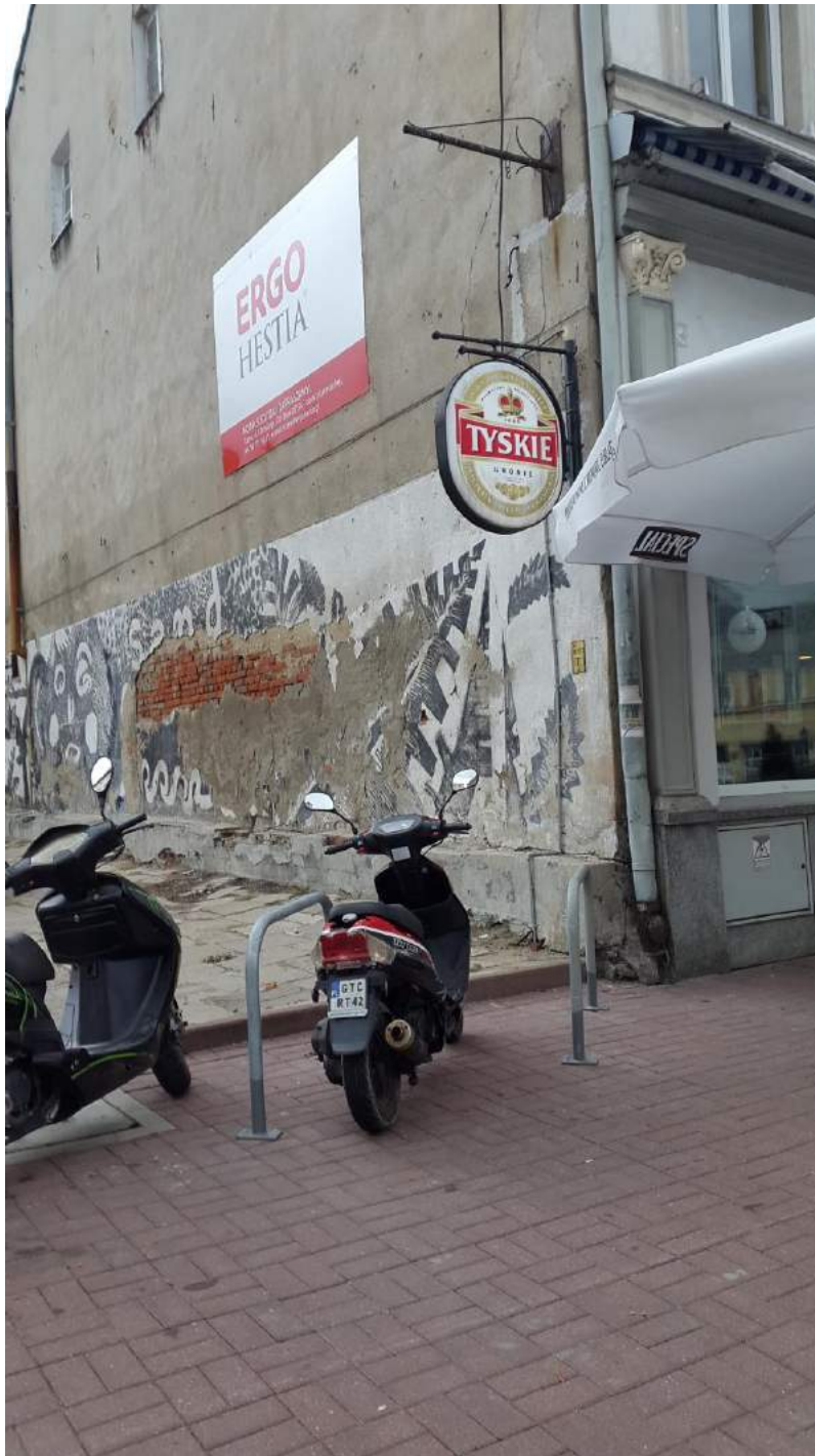
Lokalizacja: przy rogu od ul. Krótkiej, przy restauracji YOU Obecna ilość/minimalna ilość/pożądana ilość: 2/2/3
