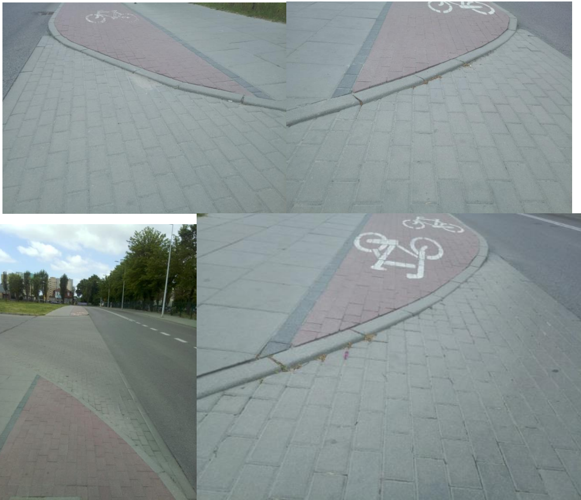
44. Umożliwienie zjazdu na ścieżkę przy niecce przy SP 11. Montaż oznakowania pionowego C-13\C-16 tj. ciąg pieszo-rowerowy z kreską poziomą.
