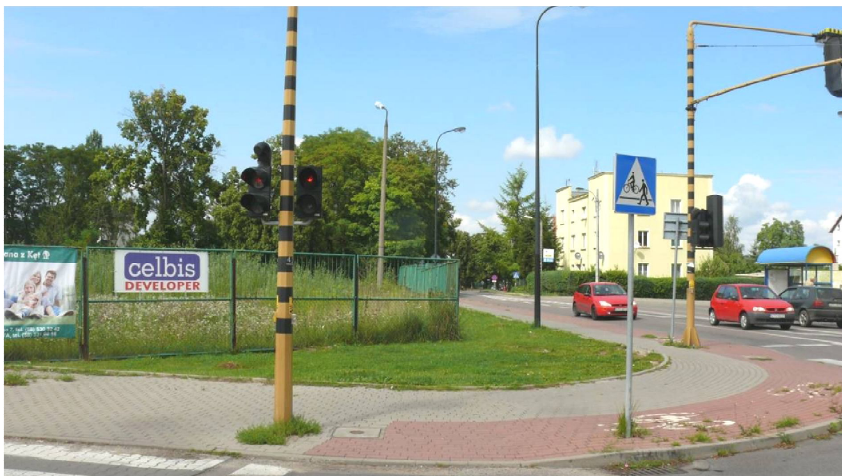
Rys. 2.27 Sprzeczne oznakowanie na drodze rowerowej.
