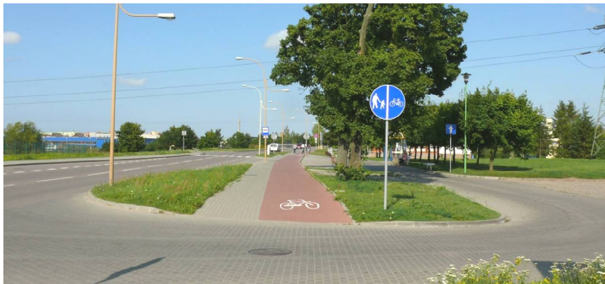
Rys. 2.24. Niewyznaczony przejazd dla rowerów i niewyrównana niweleta.
