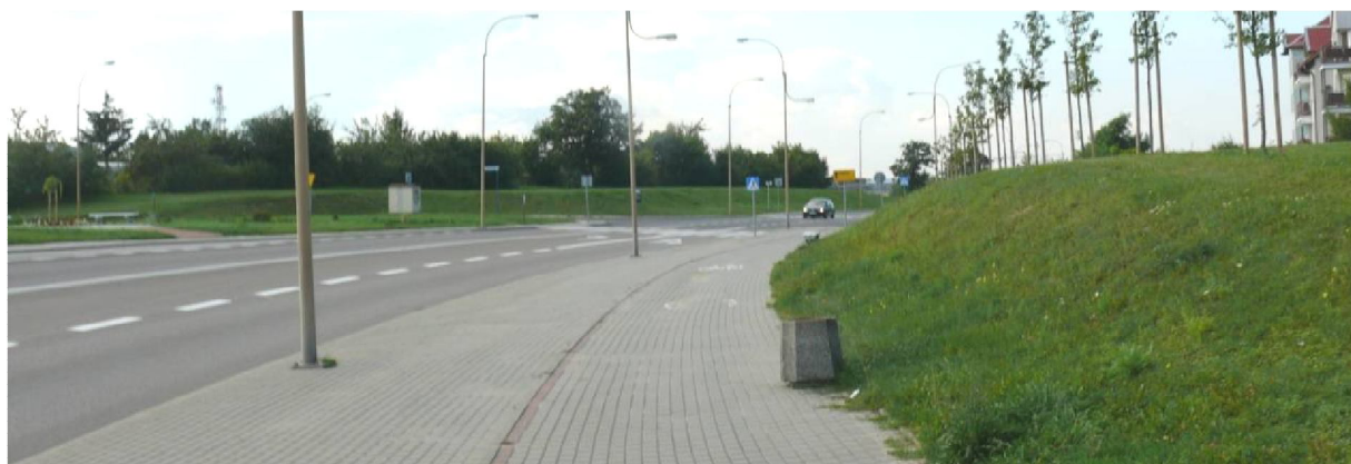
Rys. 2.9. Betonowy śmietnik na drodze rowerowej
