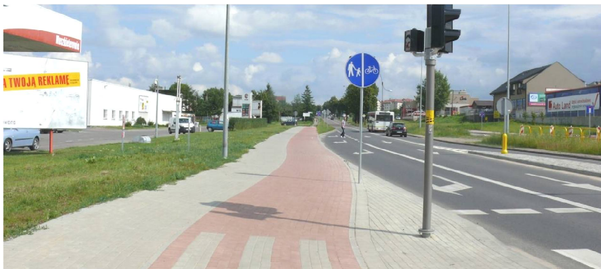
Rys. 2.31 Droga rowerowa na ulicy Jagiellońskiej.
